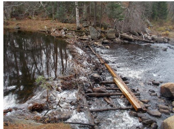
Kunjumuk Creek Dam (NYS DEC)
